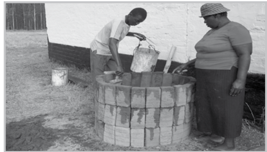
Molhe os tijolos antes de colocar cimento
