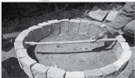
Medindo para assegurar que o tanque é circular
