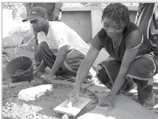
Produzindo um laje para uma latrina do tipo onde será plantada uma árvore na fossa
